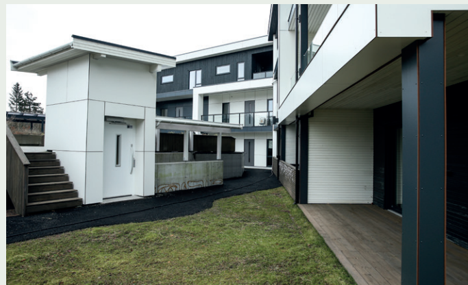
Det er lift fra parkeringskjelleren opp til inngangspartiet.
