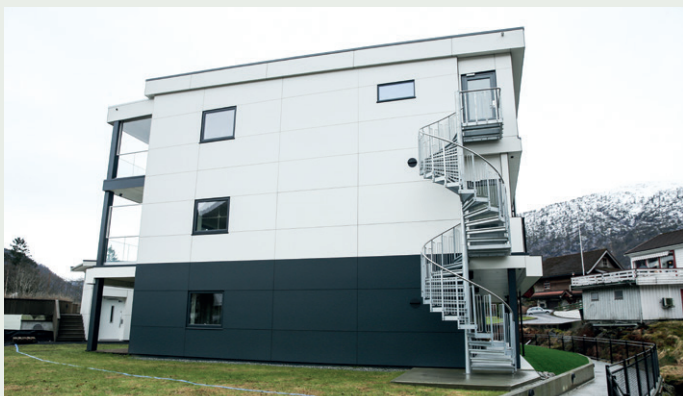
Østsiden av Smedstad Eigedom har Rockwool fasadeplater. Rømningstrappen i stål er levert av lokale Hornnes Agenturer.
