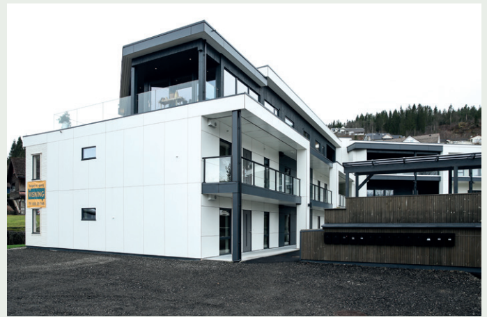
De to første etasjene har bærende konstruksjoner i betong med Rock-wool fasadeplater, mens tredje etasje er bygget i tre med trekledning på fasaden.
